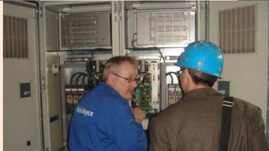
现场安装调试服务
